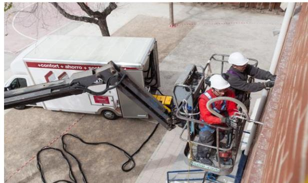
Unidad móvil para la inyección de ThermaBead e instaladores acreditados ejecutando la inyección de ThermaBead
